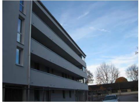
Bald bezugsfertig, die 22 neuen Wohnungen an der Wessobrunner Straße
